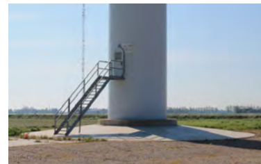
Voorbeeld schuin oplopende betonnen mastvoet in de Wieringermeer
